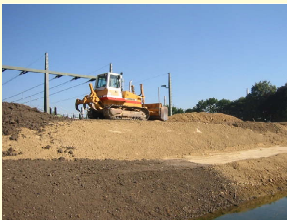
Bau eines Dammes
